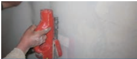
焊接防水层环向施工缝
