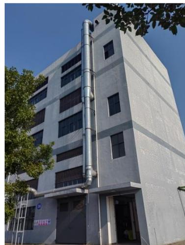
图 3.1.2-13 高分子车间废气处理装置及排气筒
