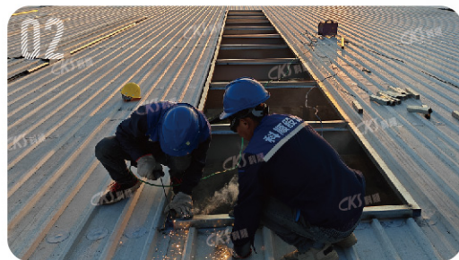
安装设备基础
