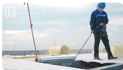
铺设玻璃丝棉
