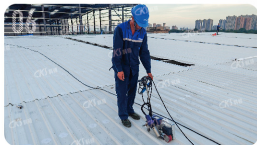
TPF塑钢瓦焊接
